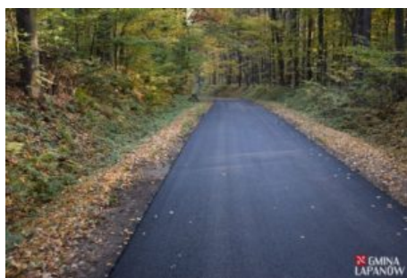
Remont drogi Kobylec-Chrostowa
