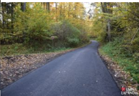
Remont drogi Kobylec-Chrostowa
